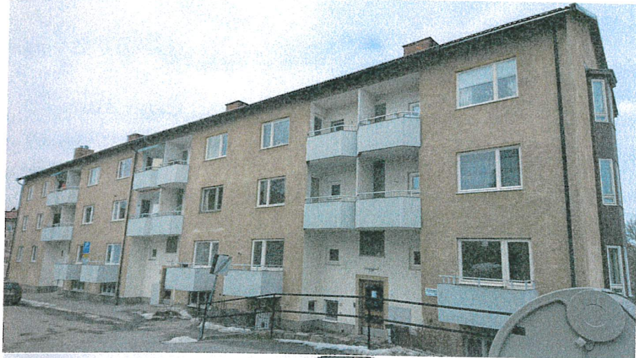
framsida bef. fasad byggår 1949
