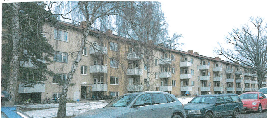
framsida bef. fasad byggår 1949
