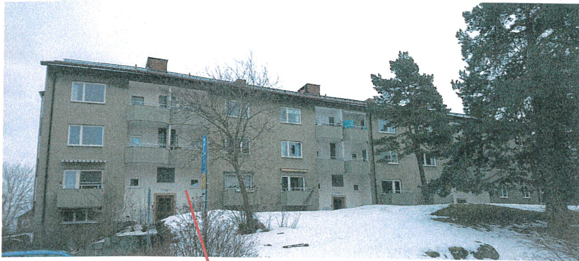
putsytor vid entréer och balkongväggar avfärgas enligt färgpm
