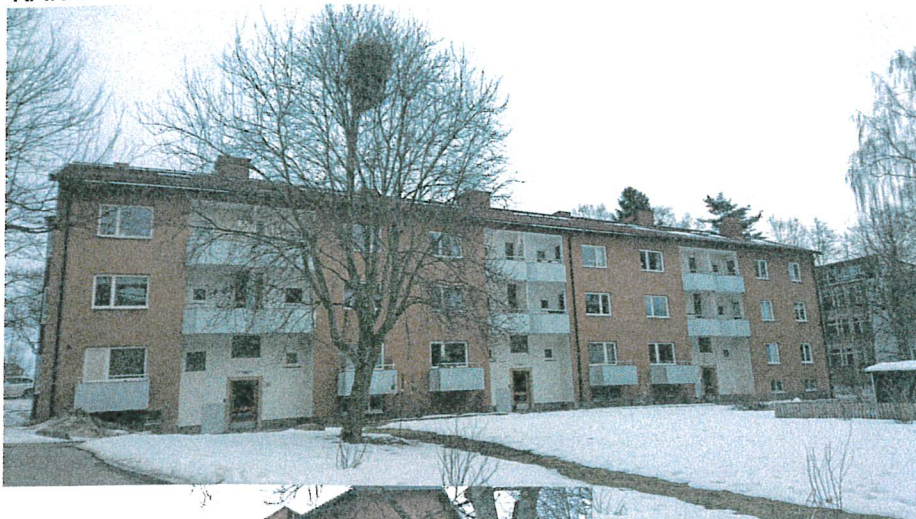
framsida bef. fasad byggår 1949
