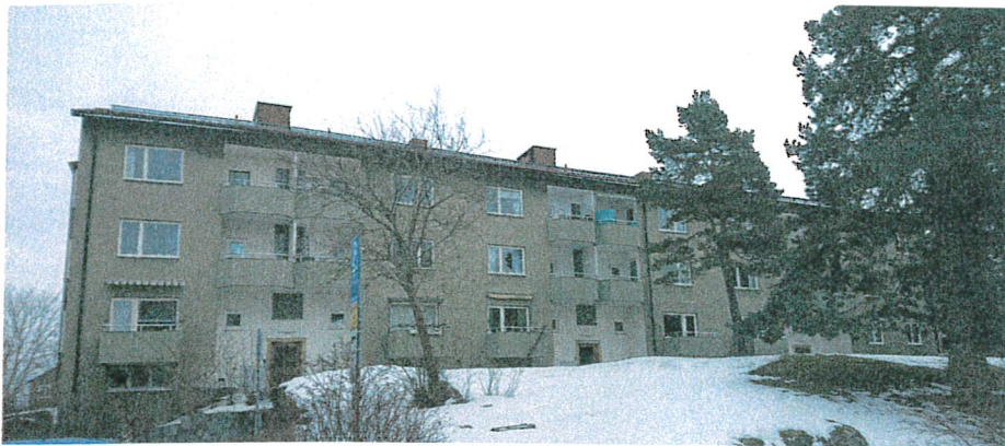
framsida bef. fasad byggår 1949
