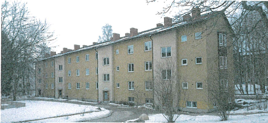
framsida bef. fasad byggår 1949
